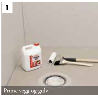
Påfør første strøk med Hey'di D20 Dampsperre
