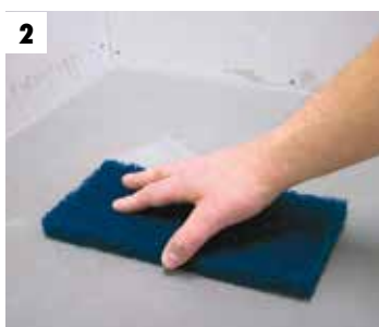
Slip underlaget lett mekanisk
