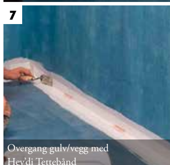
Påfør andre strøk med Hey'di D20 Dampsperre
