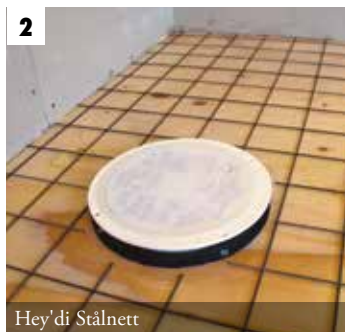
Kramp fast stålnettet til underlaget
