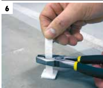
Tilpass lengden på nivåpinnen
